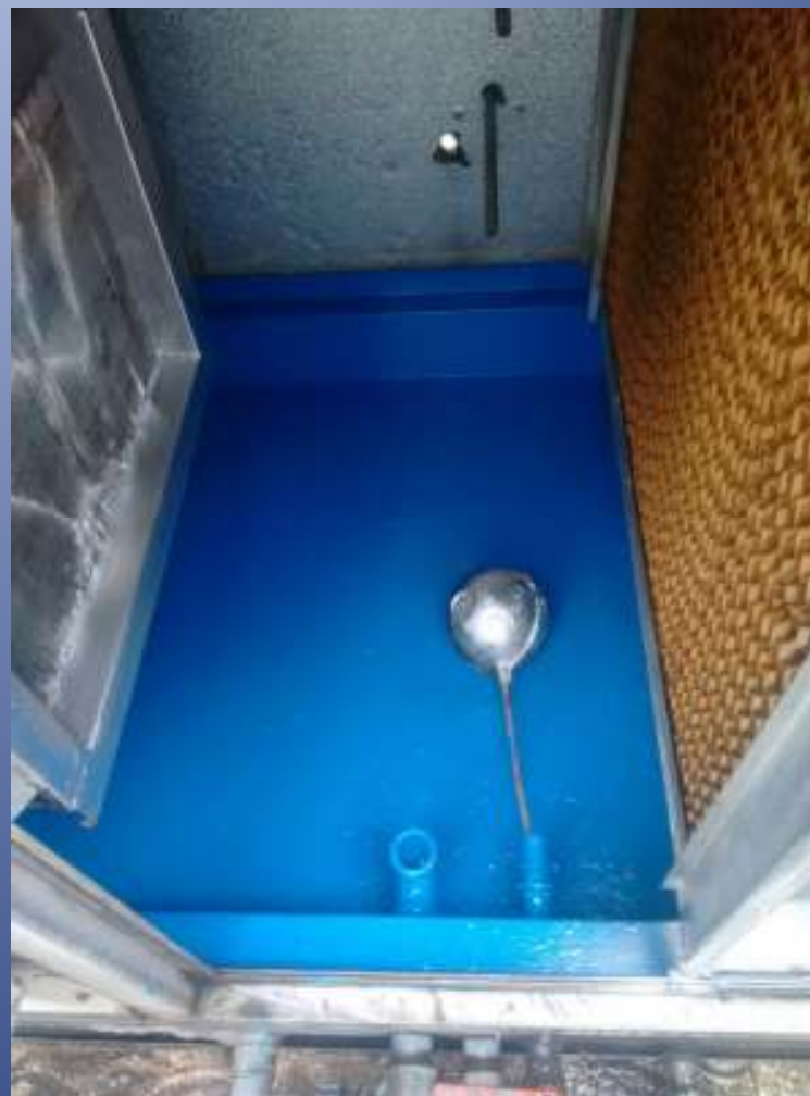
Vasca di umidificazione POST INTERVENTO
