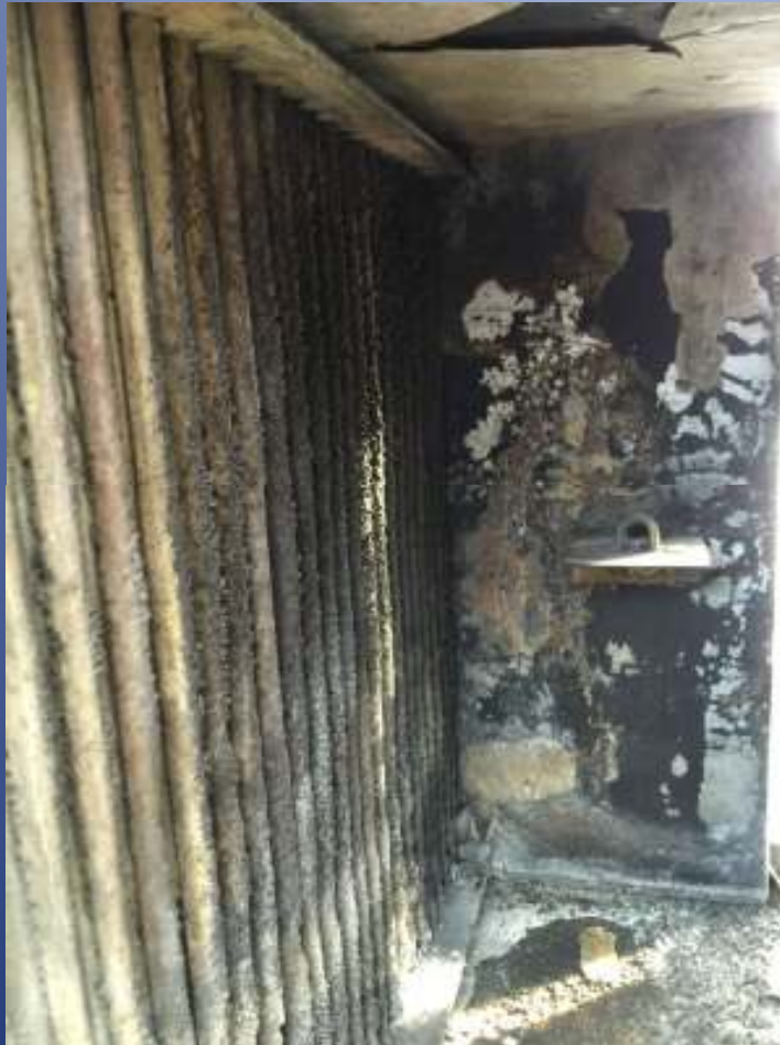
Separatore di gocce PRE INTERVENTO
