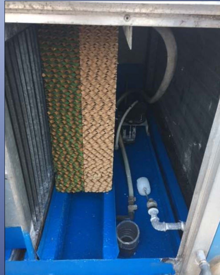
Vasca di umidificazione e pacco bagnato POST INTERVENTO
